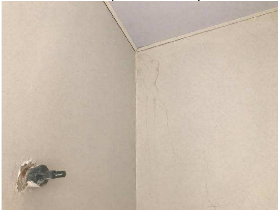
Foto 18 – Infiltração em Parede – Situação atual.
