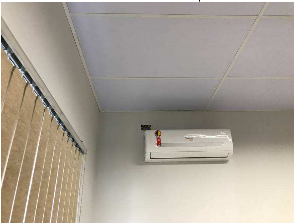
Foto 10 – Tomada externa sem espelho.
