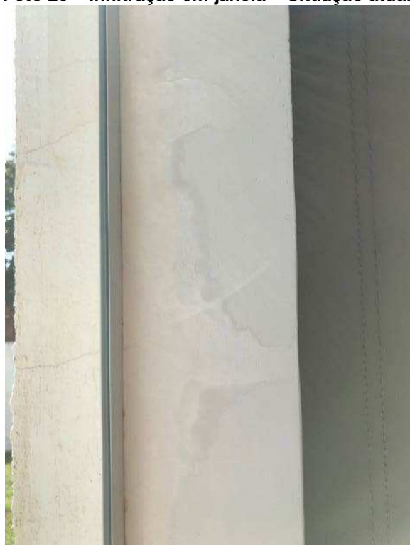
Foto 26 – Infiltração em janela – Situação atual.
