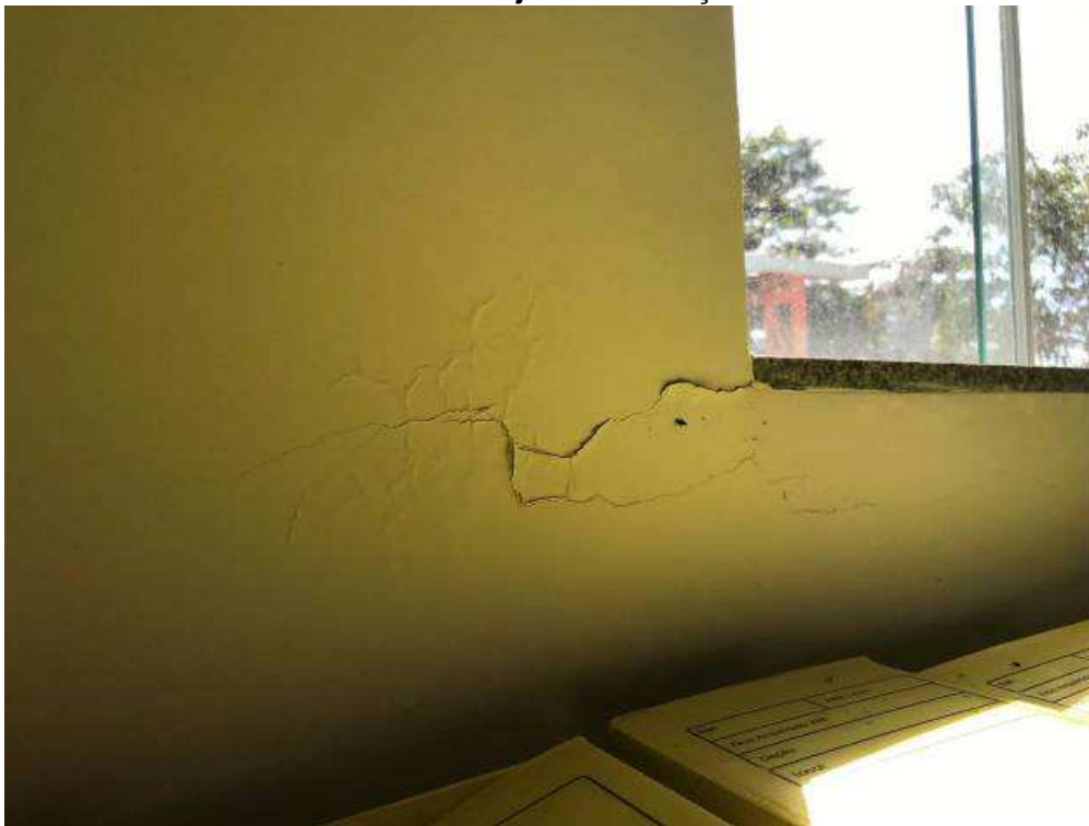
Foto 26 – Infiltração em janela – Situação atual.
