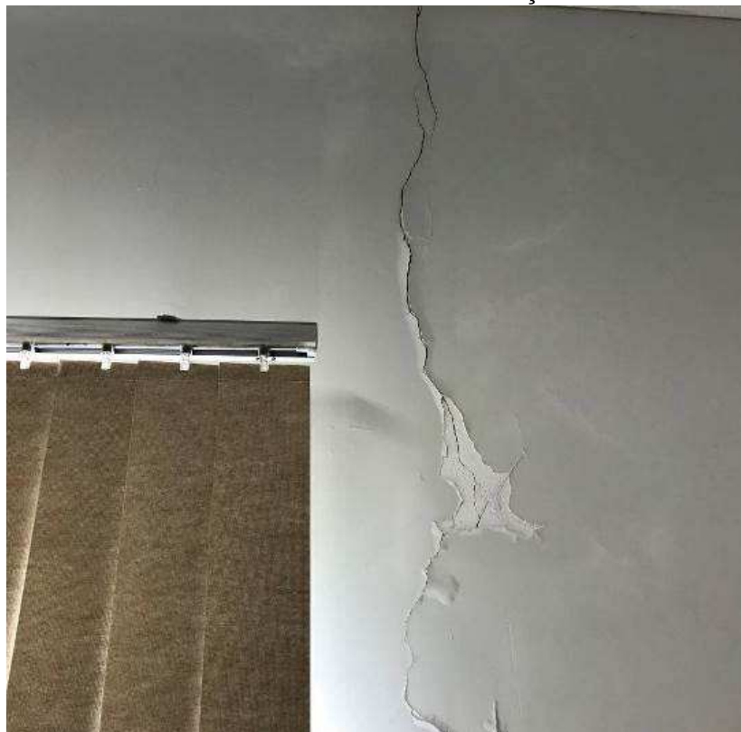
Foto 20 – Fissura em Parede – Situação atual.
